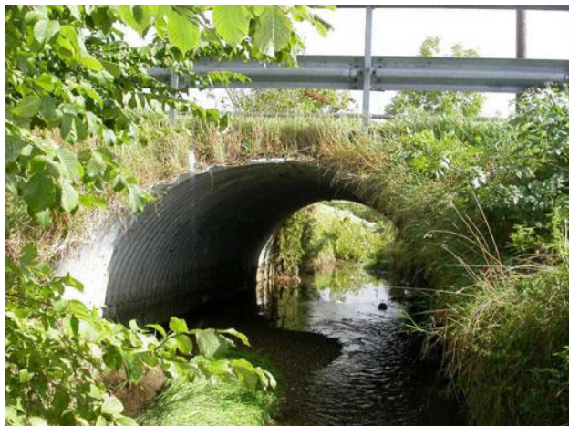
Figur 2.3. Exempel på rörbro.
